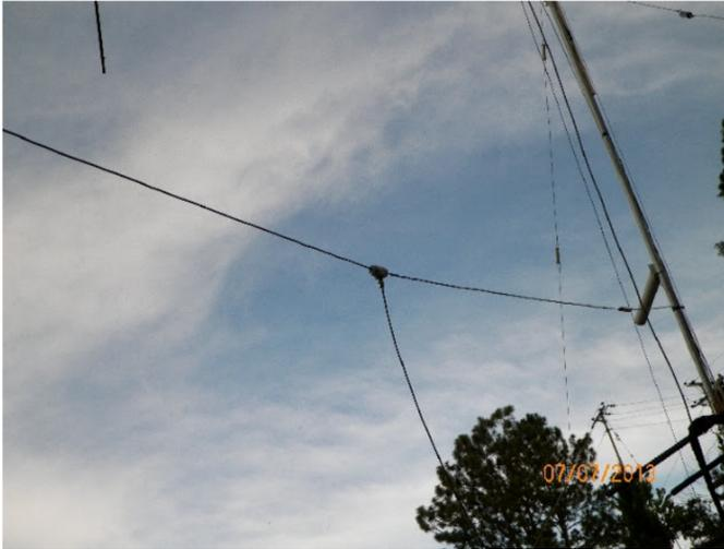
En el presente artículo se describe la construcción de una antena variante del Dipolo común, muy popular y usada por Radioaficionados en bandas HF, en este caso calculada para CB 11 Metros ( Banda Ciudadana = Frecuencia 27 MHz ), la cual se construye básicamente con cable coaxial y lleva por nombre Antena Doble-Bazooka.
