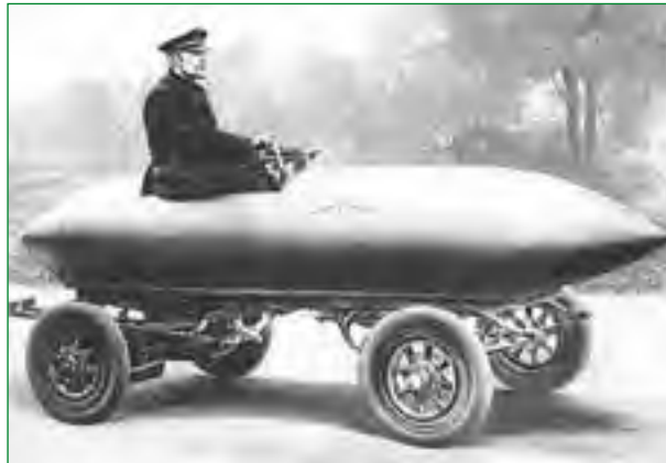
Figura 1. Regreso al futuro: hace 112 años el coche eléctrico ya era insuperable. Camille Jenatzy alcanzó en 1899 con baterías de plomo de 50 kW los 105,8 km/h.
