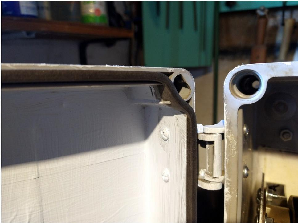
Caja inferior de conexiones, contiene el jack RJ45 para el cable de control y orificio de drenaje por condensaciones:
